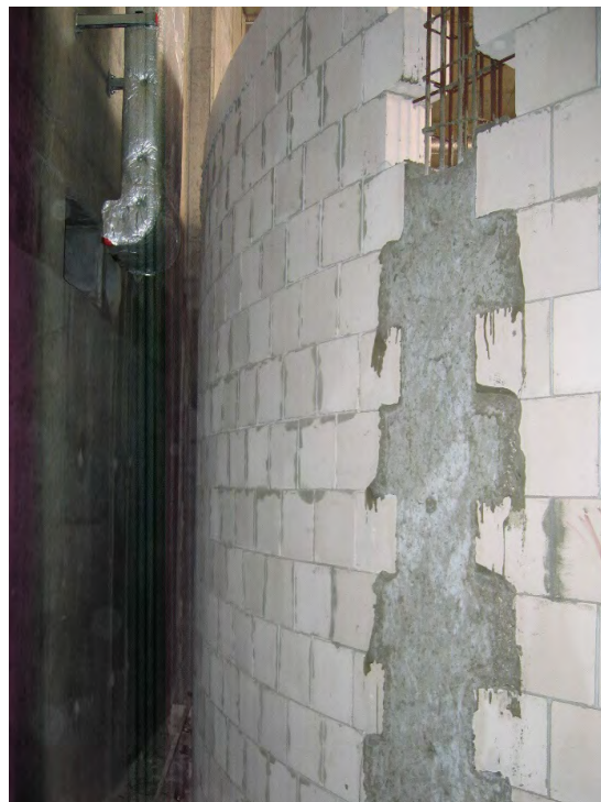
Rys. 10. Przykład zastosowania żelbetowych rdzeni w ścianach wypełniających
