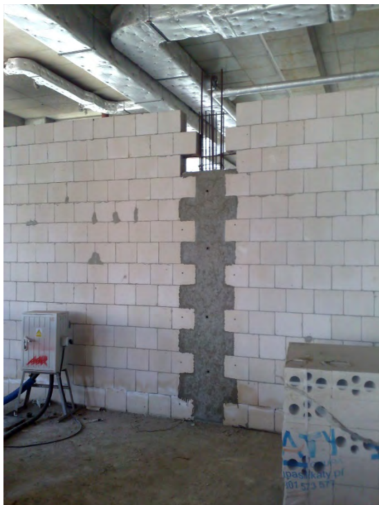
Rys. 9. Przykład zastosowania żelbetowych rdzeni w ścianach wypełniających
