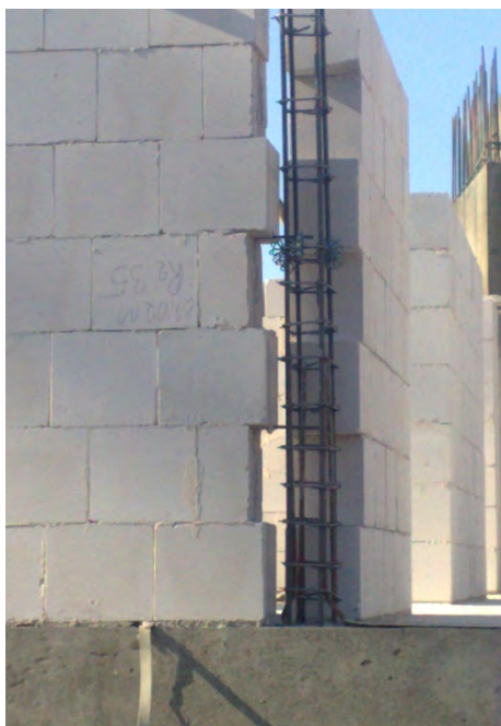
Rys. 6. Wznoszenie murów z elementów wapienno-piaskowych
