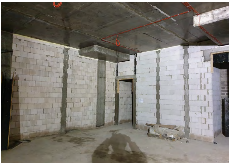
Rys. 11. Przykład zastosowania żelbetowych rdzeni w ścianach wypełniających (fot. T. Potubiński)
